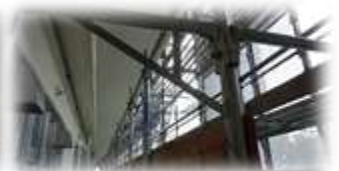
外壁に沿って足場が組み立てられました。
